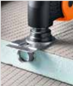
Skjæring av kanaler til vannbåren varme i gulv.
