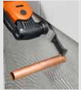
Saging i flukt med vegg på svært liten plass.
