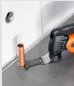
Problemfri fjerning av gamle installasjoner.
