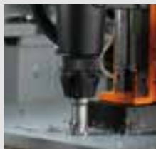
Perçage par carottage
