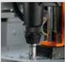
Perçage par carottage
