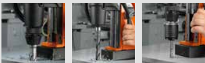
Perçage par carottage
