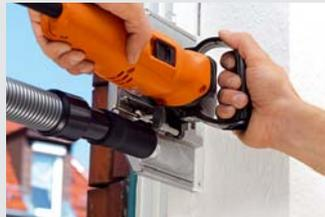
Wird die Montagefräse während des Schnitts schräg geführt, liegt die Schnittlinie direkt über dem Altfensterrahmen. Ansonsten ist der Abstand vom Altfensterrahmen 7–8 mm, Ideal für die Rahmen aktueller Isolierglasfenster.
