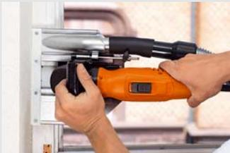
Altfenster werden mit einem einzigen Schnitt von der Fensterleibung getrennt: mit geringem Kraftaufwand, schnell und präzise – praktisch ohne Staubanfall.
