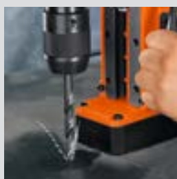
Perforación con broca espiral
