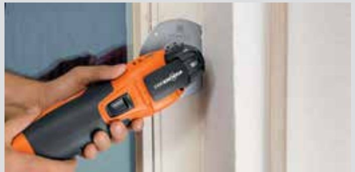
Kapa metallfästen vid demontering av gamla fönster.
