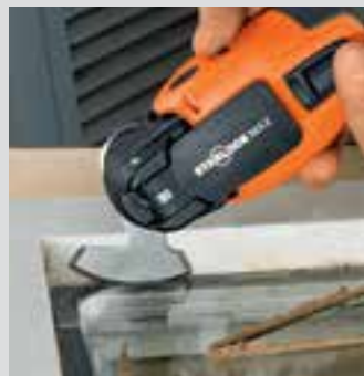
Ta ur kittade isolerglas.
