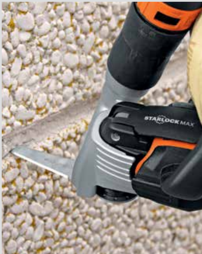
Vid farligt fogmaterial (t.ex. PCB) används dammsugningen.
