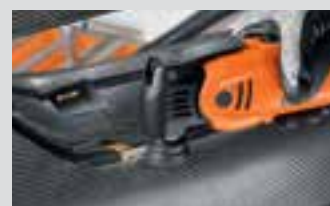
Avgrändning av delar av kolfiberplast.
