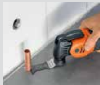
Ta bort gamla installationer utan problem.
