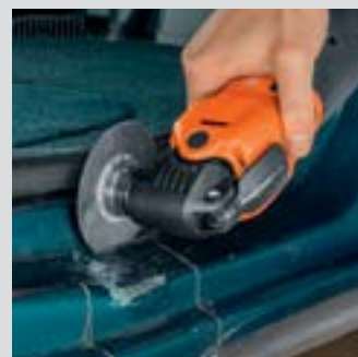
Vetemedésmentes fűrészelés, tiszta vágási élék, vékony vágási vonal – előnyös tulajdonságok a karosszérián végzett munkák során.
