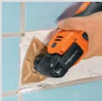
Újrafugázás előtt csiszolja simára a csemperagasztót.
