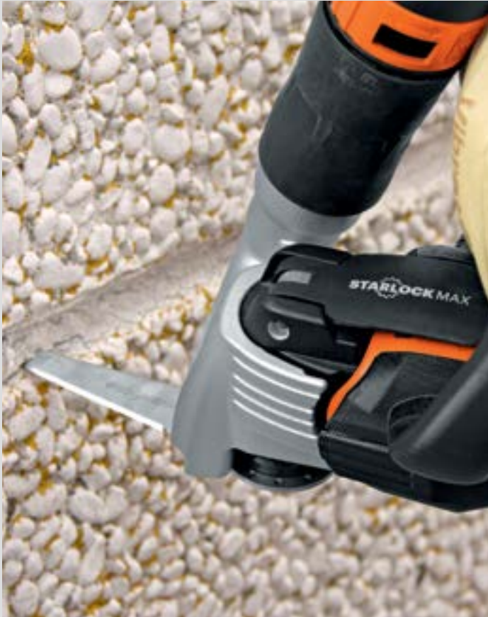
Veszélyes fugaanyagok (pl. PCB) megmunkálása során porelszívót kell használni.
