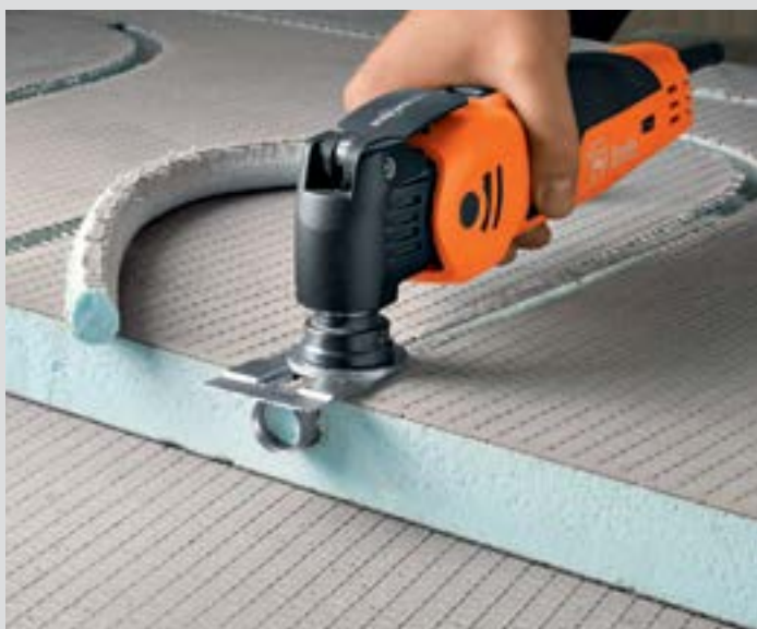
Csatornák vágása melegvízes padlófűtéshez.
