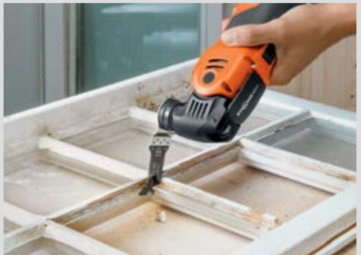
Régi ablakok felújítása.
