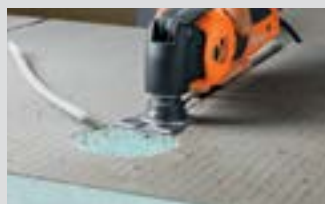
Villanszerelési munkák előkészítése.
