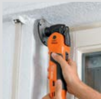
Redőnyszekrény-burkolatok kibontása.
