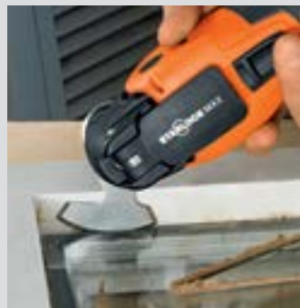
Kittágyba helyezett szigetelő üveglapok kivágása.
