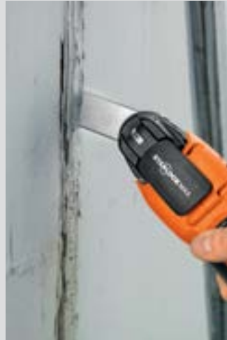
Elasztikus fugatömítő anyagok eltávolítása magas- és mélyépítésben.
