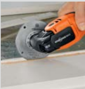
Szögek átvágása az üvegszegélyeknél.
