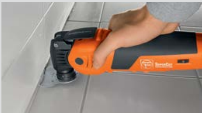
Elasztikus fugatömítő anyagok eltávolítása.
