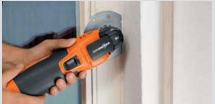
Fém rögzítőkötések átvágása régi ablakok szétszerelése során.
