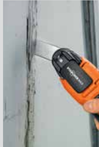
Fjerning av elastisk fugemasse ved bygging i høyden og dybden.
