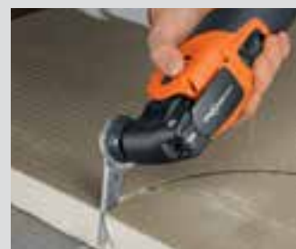
Tilskjæring av byggeplater.
