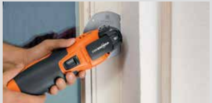
Kapping av metallfestebånd ved demontering av gamle vinduer.
