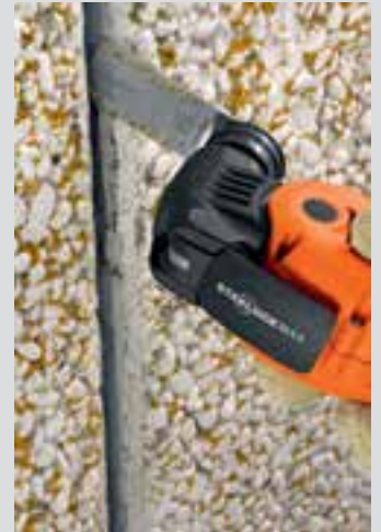
Rubbing av fugesider før ny fuging.
