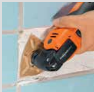
Slip ned fliselim før ny fuging.
