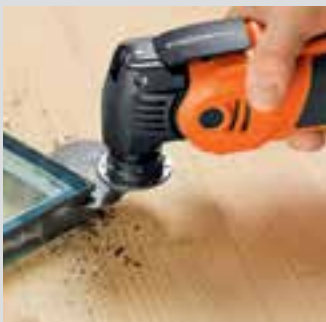
Separasjon av isoleringsglassruter.
