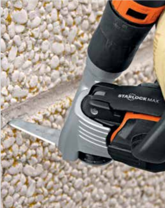
Bij gevaarlijke voegmaterialen (bijv. PCB) wordt de stofafzuiging gebruikt.
