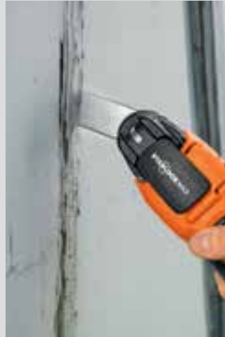
Verwijderen van elastische voegmaterialen in hoog- en laagbouw.
