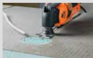
Elektrische installatie voorbereiden.
