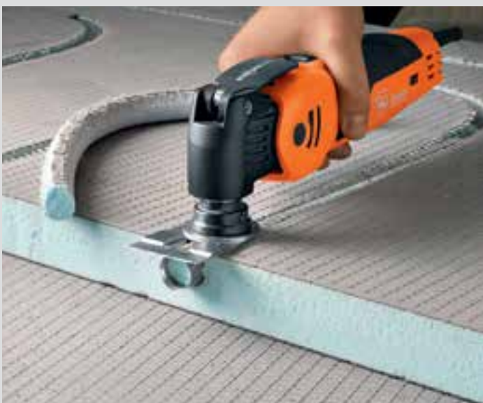
Goten snijden voor warmwater-vloerverwarming.
