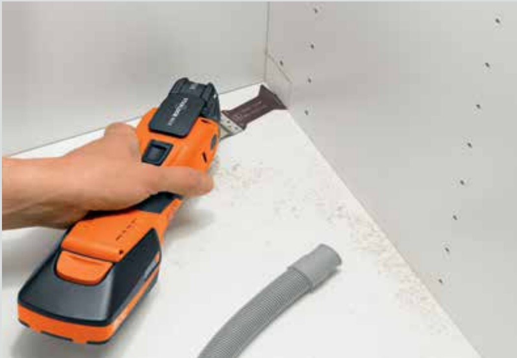
Uitsparingen bij meubels op moeilijk toegankelijke plaatsen.
