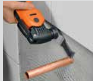
Met de muur gelijk zagen op de krapste plekken.
