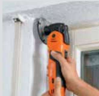
Afdekkingen van rolluikbakken opensnijden.
