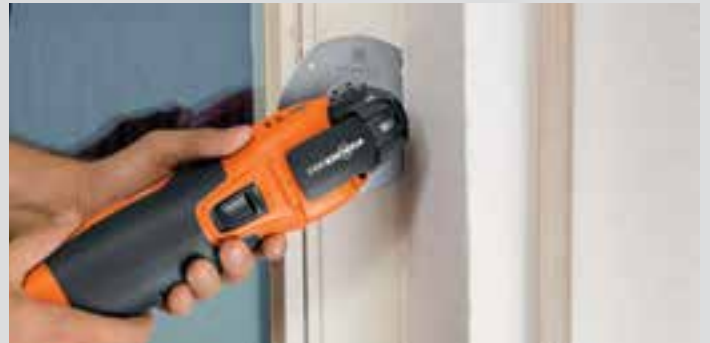
Metalen bevestigingsbanden bij de demontage van oude ramen doorsnijden.
