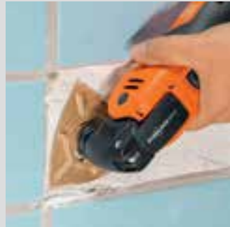
Tegellijm vóór het opnieuw voegen vlak schuren.
