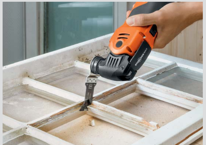
Restauration de vieilles fenêtres.
