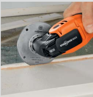
Tronçonnage des clous sur les pareclos.
