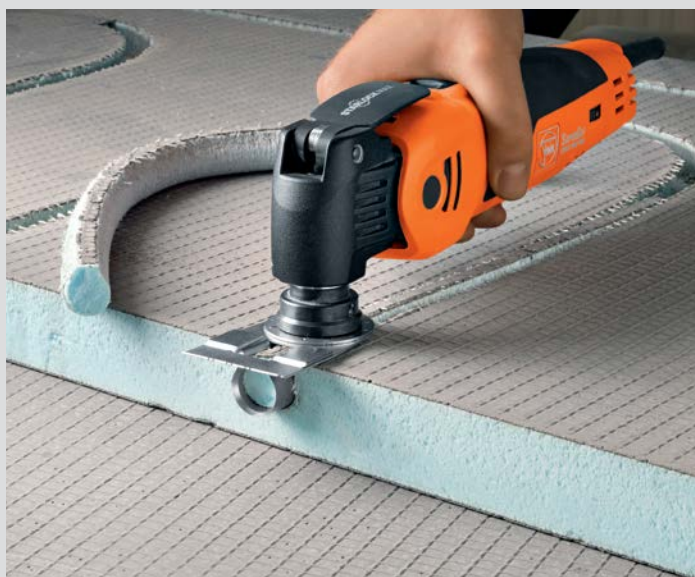
Coupe de conduites d'eau chaude et de chauffage au sol.
