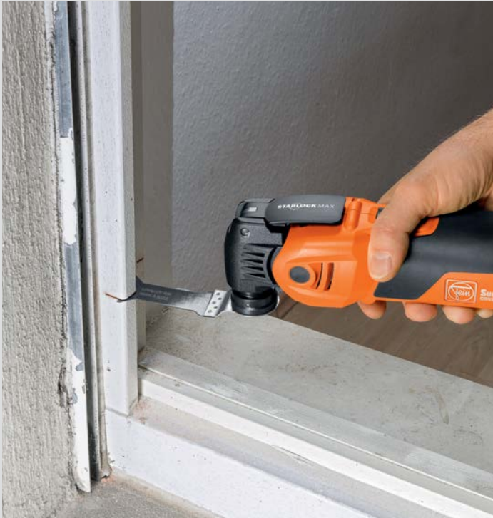
Tronçonnage des châssis de fenêtres.
