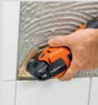
Raspare in piano il collante per piastrelle.
