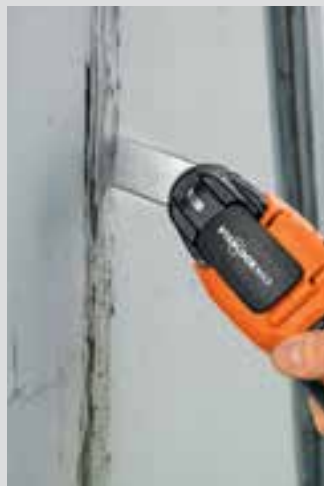
Rimozione di sigillante elastico per giunti in applicazioni di edilizia civile ed industriale.
