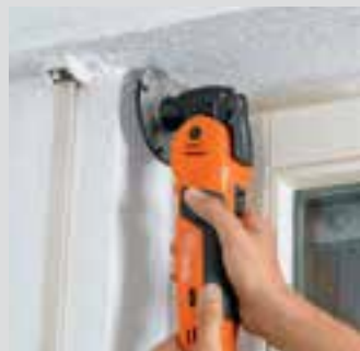
Distacco delle coperture di cassonetti delle tapparelle.
