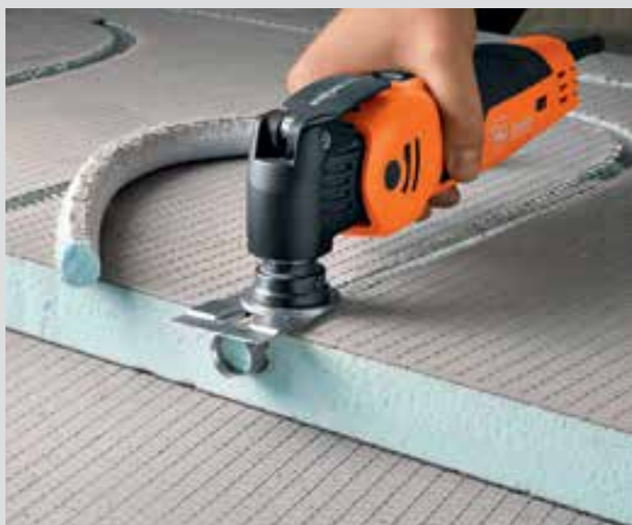
Taglio di canaline dell'impianto di riscaldamento ad acqua calda a pavimento.
