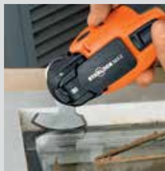
Taglio di vetri isolanti fissati con mastice.
