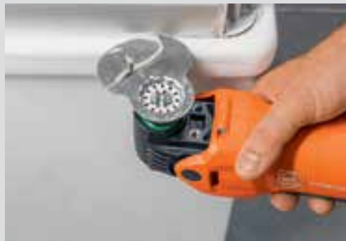
Rimozione di giunti elastici.
