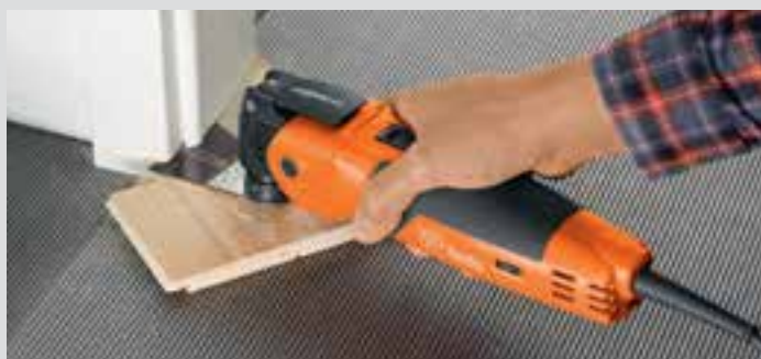
Infissi accorciati perfettamente.
