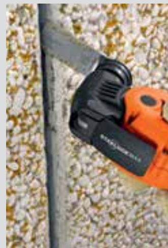
Irruvidimento dei fianchi dei giunti prima di rinnovarli.
