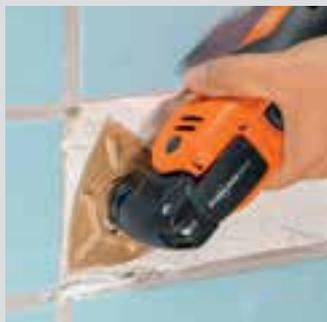
Ponçage à ras de la colle à carreaux avant la pose de nouveaux joints.
