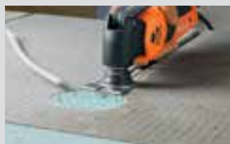
Подготовка к установке электрооборудования.
