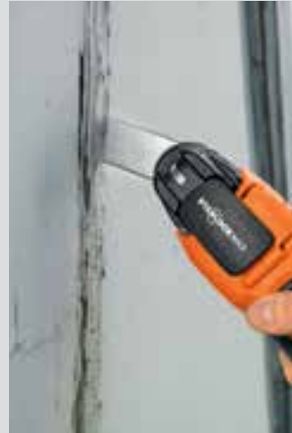
Удаление эластичных уплотнительных материалов в высотном и подземном строительстве.
