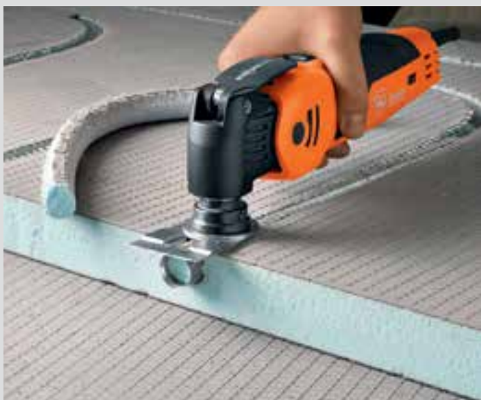
Вырезание каналов для подвода горячей воды в системах обогрева пола.
