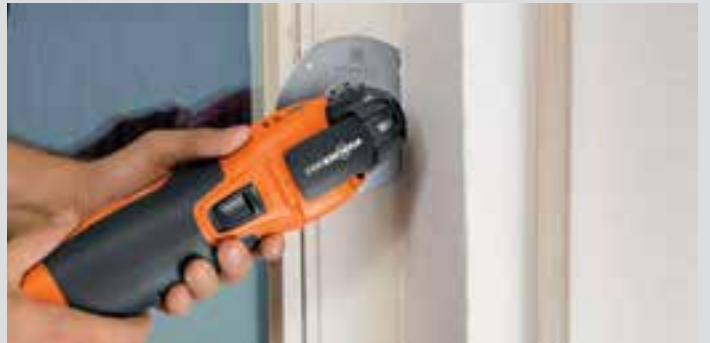
Разрезание металлических крепежных скоб при демонтаже старых окон.
