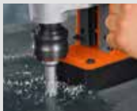
Perçage par carottage
