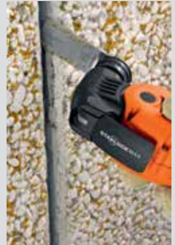
Opruning af fugesider inden genopfugning.
