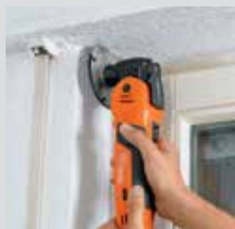
Skæring af vindueskarne.
