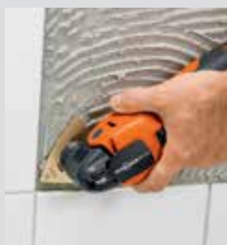
Fliseklæber raspes helt plant.
