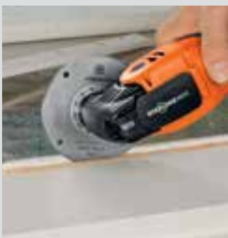
Skæring af søm i glaslister.
