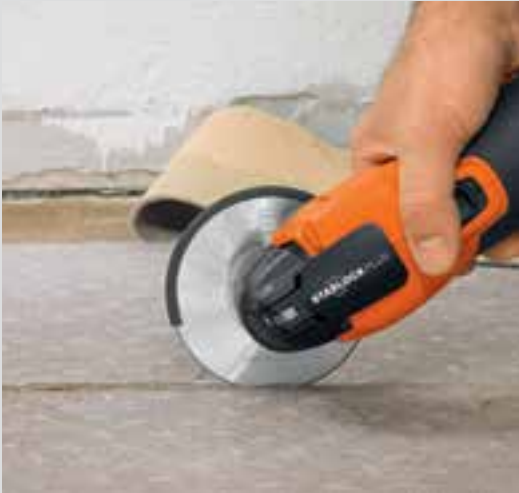
Gamle gulvbelægninger fjernes hurtigt, nemt og fuldstændigt.
