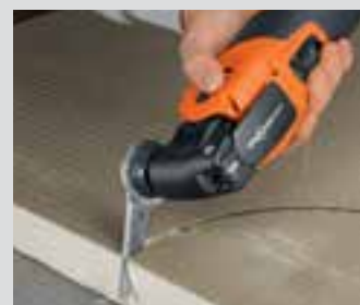
Tilskæring af byggeplader.
