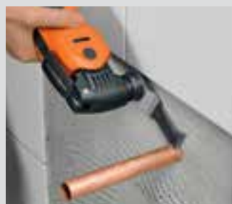
Savning plant med væggen ved meget dårlige pladsforhold.
