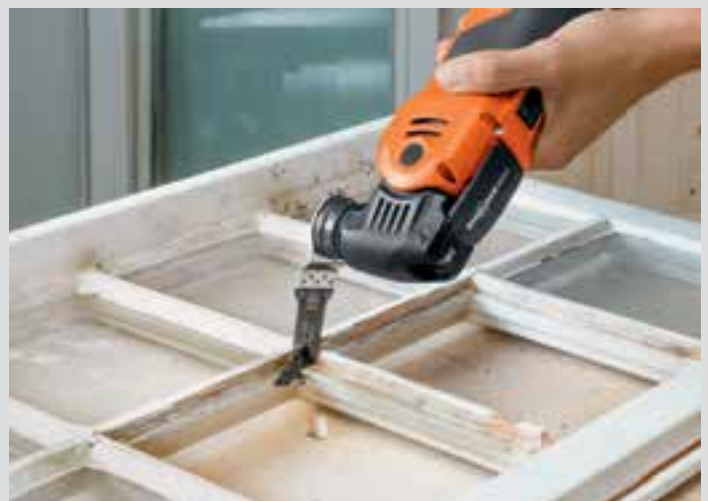
Restaurering af gamle vinduer.
