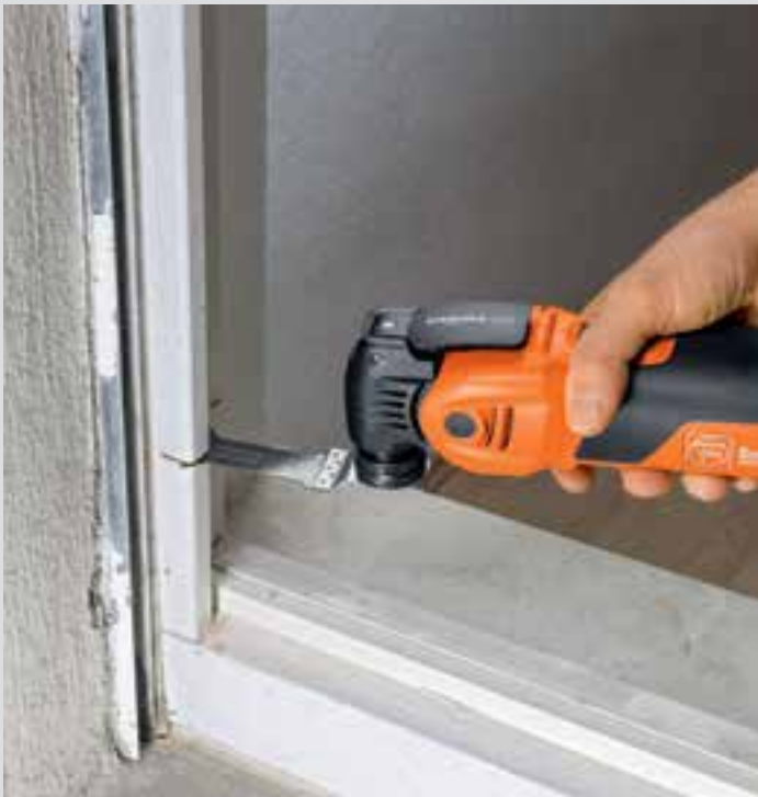
Skæring af vinduesrammer.
