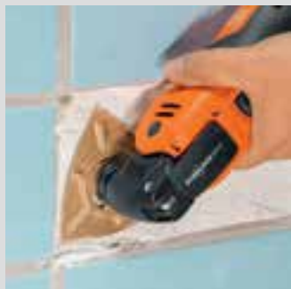
Planslibning af fliseklæber inden nye fuger trækkes.
