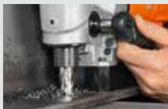
Perforación con corona
