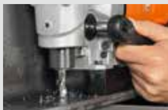
Perforación con broca espiral
