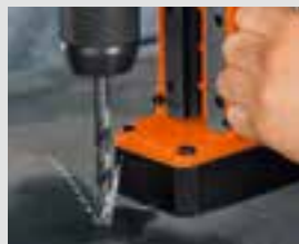
Perforación con broca espiral
