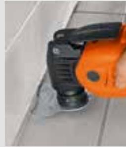
Elastische Fugendichtstoffe entfernen.
