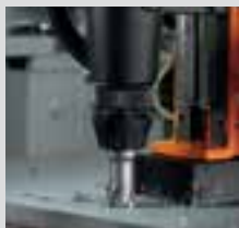
Perçage par carottage
