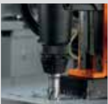
Perçage par carottage
