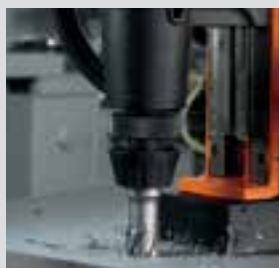
Perçage par carottage
