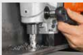
Perçage par carottage
