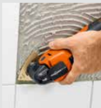
Fliseklæber raspes helt plant.
