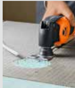
Forberedelse af elinstallation.
