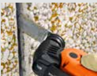
Opruning af fugesider inden genopfugning.
