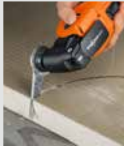
Tilskæring af byggeplader.
