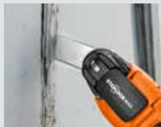
Fjernelse af elastisk fugemateriale ved anlægsarbejde og byggeri.
