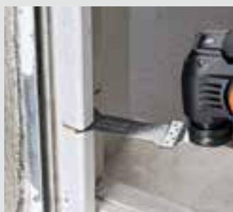
Skæring af vinduesrammer.
