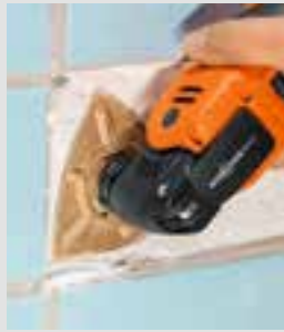
Planslibning af fliseklæber inden nye fuger trækkes.
