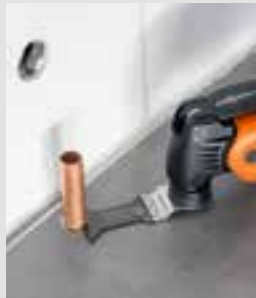
Problemløs fjernelse af gamle installationer.
