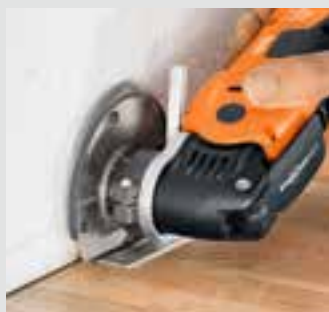
Fremragende efterskæring af ekspansionsfuger.
