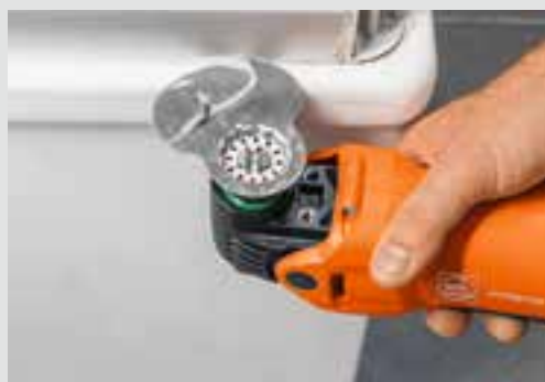
Aansluitvoegen verwijderen.
