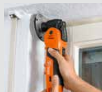
Afdekkingen van rolluikbakken opensnijden.
