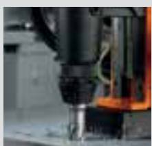
Perçage par carottage
