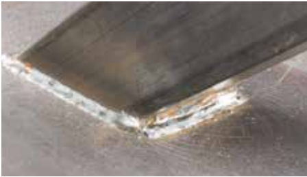
Unbearbeitete Schweißnähte mit Anlauffarben in Metallkonstruktionen
