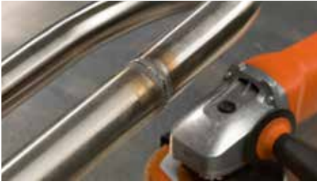
Schweißnaht auf Profilen oder Kanten
