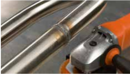
Soldadura en perfiles o cantos
