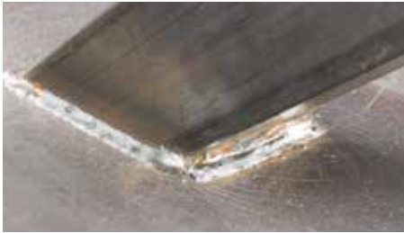
Soldaduras no mecanizadas con colores de revenido en construcciones metálicas
