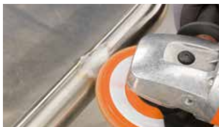
Avverkning av svetsfogen utan att den angränsande ytan skadas
