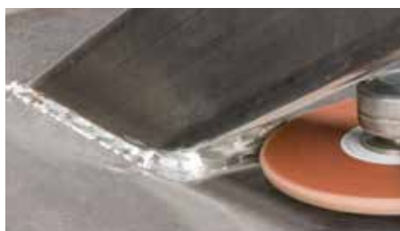
Slipning av svetsfogarna i svårtåtkomliga konstruktioner
