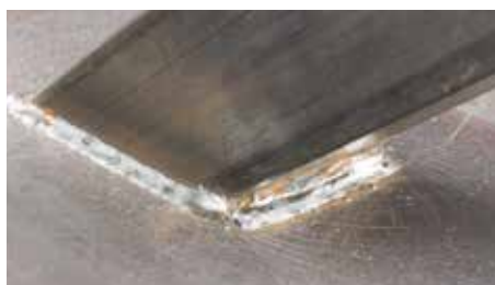
Obearbetade svetsfogar med anlöpningsfärger i metallkonstruktioner
