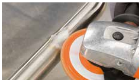
Úber zvarového švu bez poškodenia susediaceho povrchu
