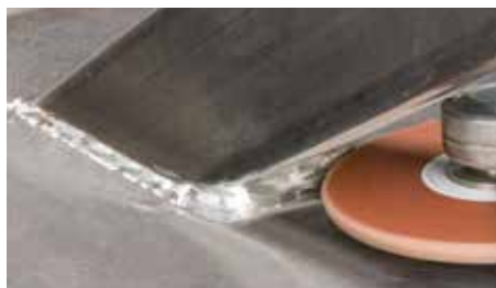
Brúsenie zvarových švov v ťažko dostupných konštrukciách
