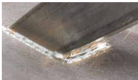
Nespracované zvarové švy s nábehovými farbami v kovových konštrukciách
