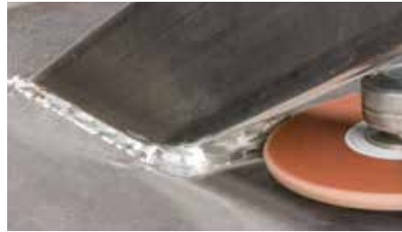
Afslijpen van de lasnaden bij moeilijk toegankelijke constructies
