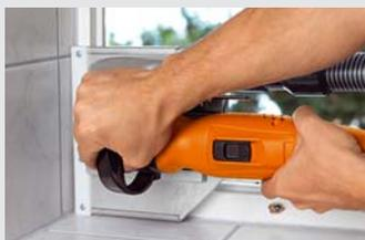
Le disque diamant sectionne aisément le carrelage et le crépi. La fraise de montage FEIN vient à bout même des ancrages métalliques.
