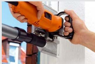
Si la fraise de montage est guidée obliquement pendant la coupe, la ligne de coupe se trouve directement au-dessus du cadre de la vieille fenêtre. Sinon, la distance du cadre de fenêtre est de 7-8 mm, donc idéale pour les cadres de fenêtres isolantes modernes.
