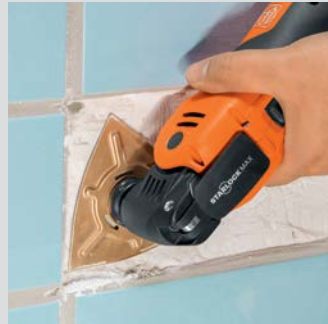
Desbaste de fondos de colas de baldosas antes de la nueva disposición.
