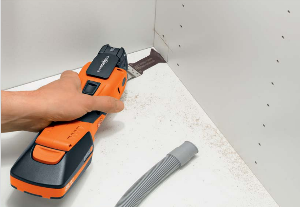
Escotaduras en muebles en lugares de difícil acceso.
