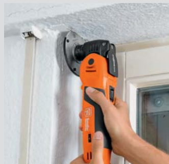
Seccionar cubiertas de cajas de persianas arrollables.
