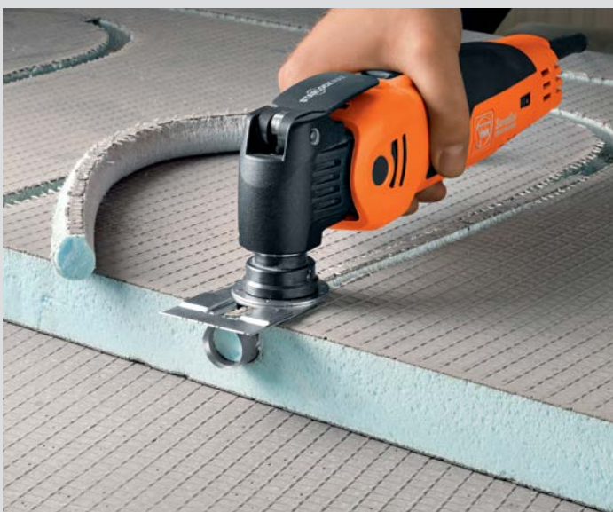
Corte de canales para calefacción de suelos con agua caliente.
