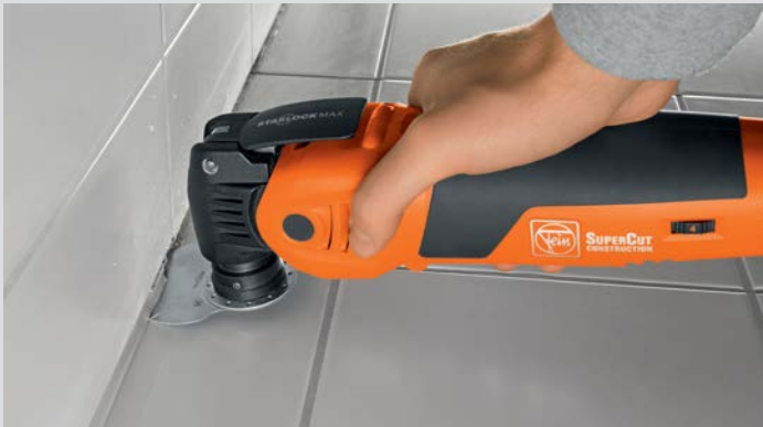
Eliminar materiales de juntas elásticos.
