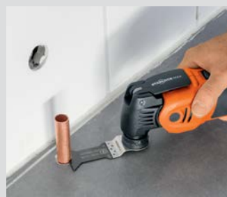
Eliminación de instalaciones antiguas sin problemas.
