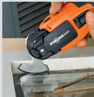
Separar lunas de vidrio aislante dispuestas en lecho de masilla.
