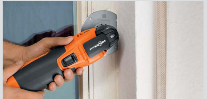
Separar tiras de fijación metálicas al desmontar ventanas antiguas.
