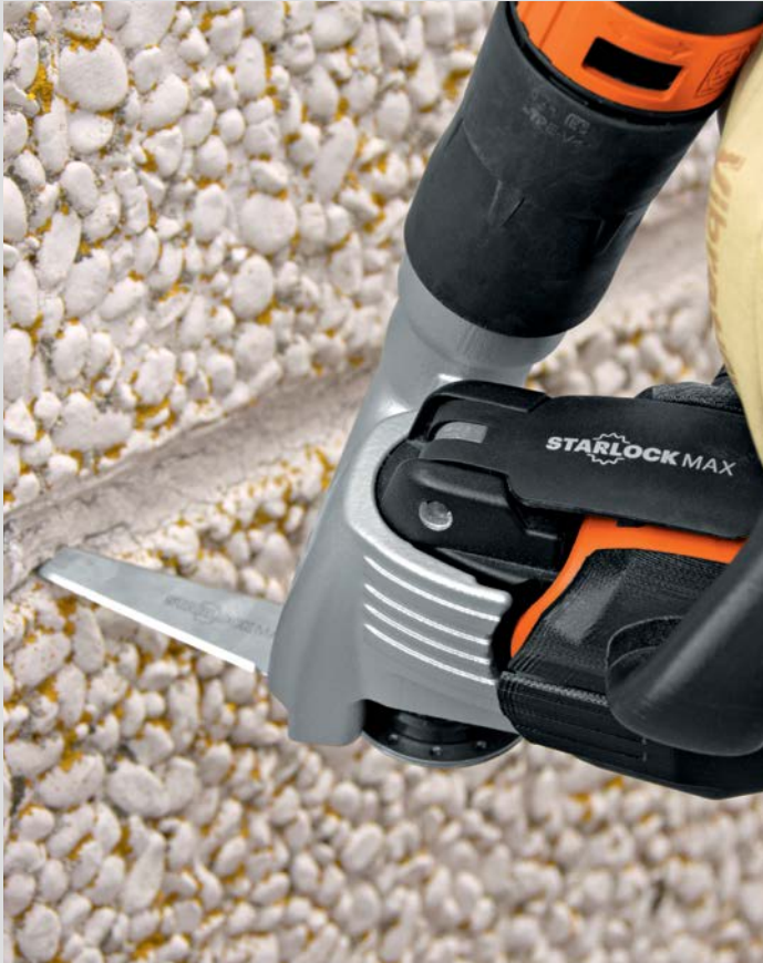
En caso de materiales de juntas peligrosos (p. ej. PCB) se utiliza la aspiración de polvo.
