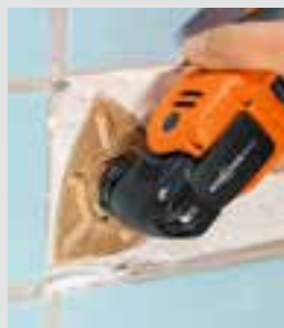
Planslipa kakelfix före omfogningen.
