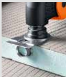
Skära kanaler för golvvärmerör.
