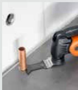
Ta bort gamla installationer utan problem.
