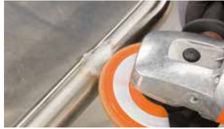
Ponçage du cordon de soudure tout en préservant les surfaces adjacentes.
