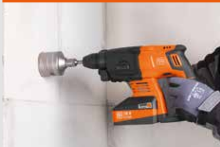
Perçage de trous de 68 mm dans la brique.
