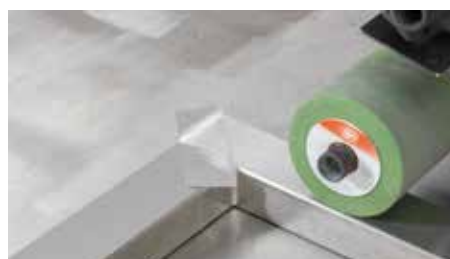
Recouvrement de l'onglet avec la bande inox et égalisation.
