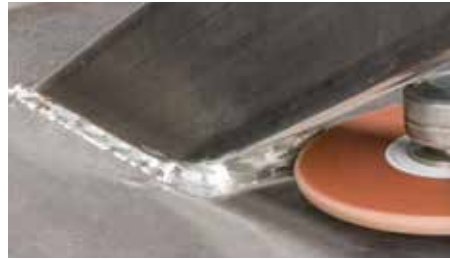
Ponçage des cordons de soudure dans des endroits exigus.
