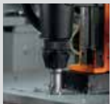
Perforación con corona
