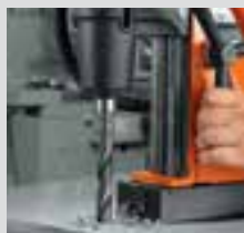
Perforación con broca espiral
