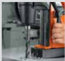
Perforación con broca espiral*
