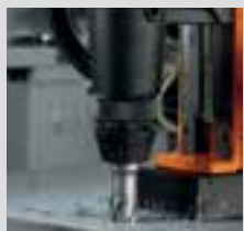
Perforación con corona
