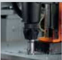
Perforación con corona
