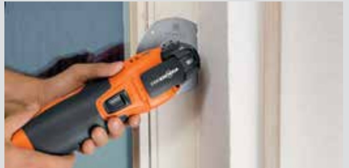
Rozcinanie metalowych taśm mocujących przy demontażu starych okien.
