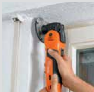
Rozcinanie skrzynek żaluzji.
