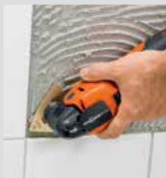
Równe zdzieranie kleju do płytek.
