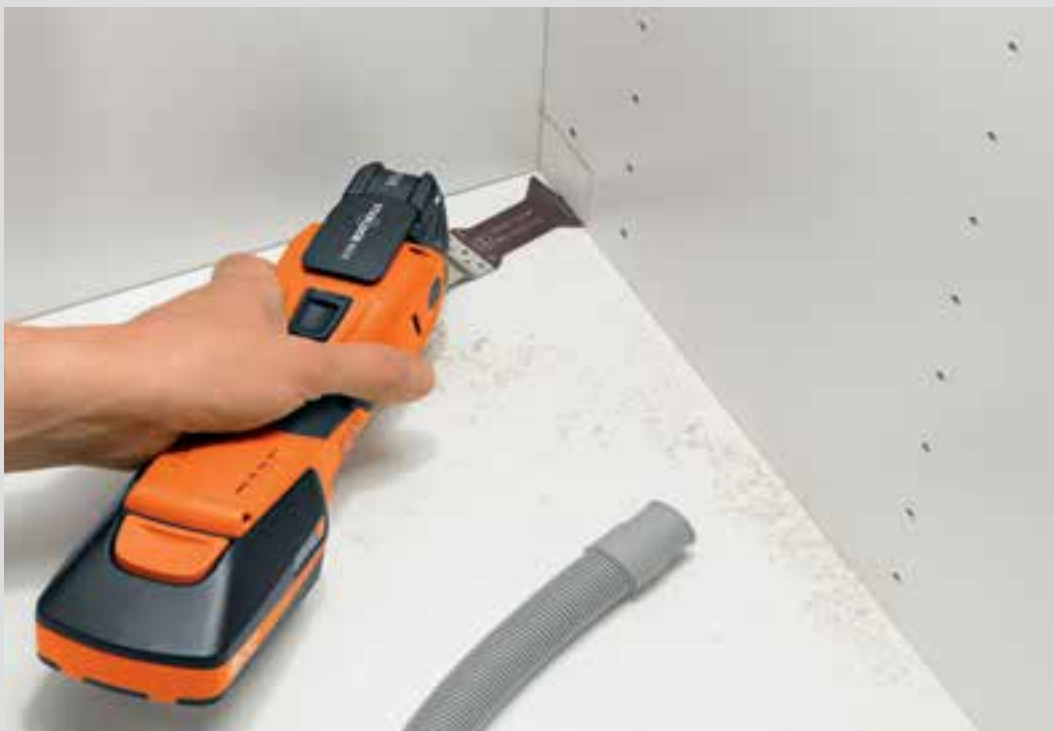
Wycinanie otworów w meblach w trudno dostępnym miejscu.
