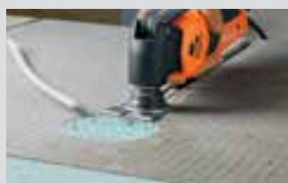
Przygotowanie instalacji elektrycznych.
