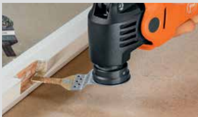
Pilirea curată și precisă a decupajelor.
