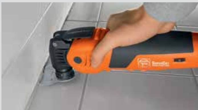
Îndepărtarea materialelor de etanșare elastice ale rosturilor.
