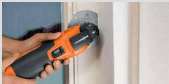
Tăierea benzilor de fixare metalice la demontarea ferestrelor vechi.
