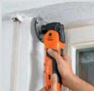
Separarea capacelor casetelor de rulouri.
