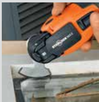
Separarea geamurilor izolante montate pe pat de chit.
