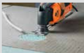
Pregătirea instalației electrice.
