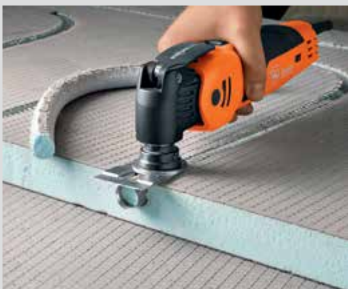
Tăierea canalelor pentru apă caldă și încălzire în pardoseală.
