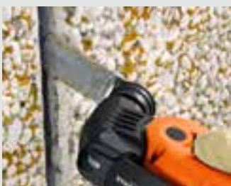
Fugaszélek érdesítése újrafugázás előtt.
