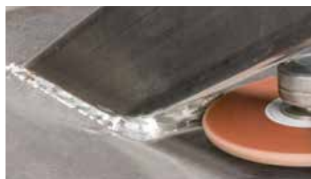
Broušení svarů v obtížně přístupných konstrukcích
