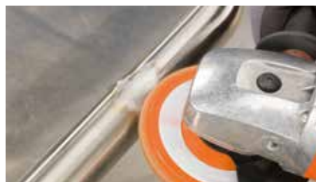
Úběr svaru bez poškození sousedních ploch
