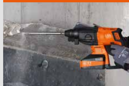
Fjernelse af betonrester.
