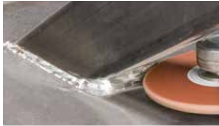
Slibning af svejsesømmene i svært tilgængelige konstruktioner
