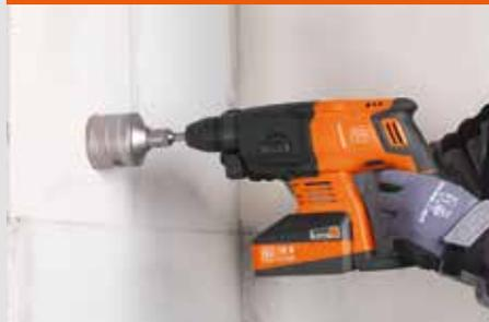
Setzen von 68-mm-Steckdosenlöchern in Mauerwerk.
