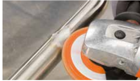
Wegslijpen van de lasnaad zonder beschadiging van het aangrenzende oppervlak
