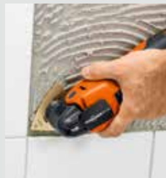
Éliminer à ras la colle à carreaux avec une râpe.
