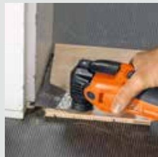
Travail au ras des surfaces.
