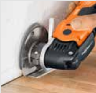
Recoupe parfaite des joints de dilatation.
