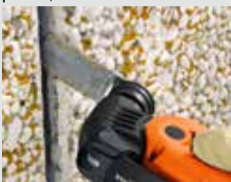
Grattage des flancs avant la pose de nouveaux joints.
