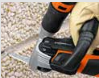
L'aspiration des poussières est utilisée pour les matériaux de jointoiement dangereux (PCB par ex.).
