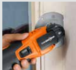
Tronçonnage des pattes de fixation métalliques lors du démontage des vieilles fenêtres.
