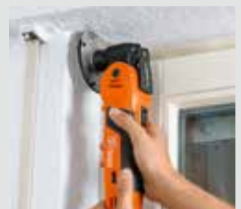
Tronçonnage des recouvrements de caissons de volet roulant.
