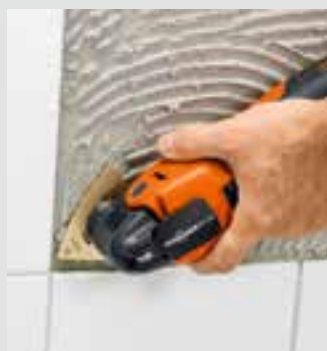
Rovné obrúsenie lepidla na dlaždice.
