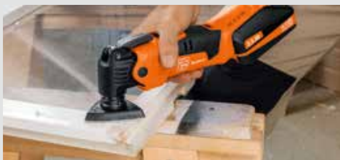
Kompletná renovácia okien – všade, aj bez pripojenia do elektriny.
