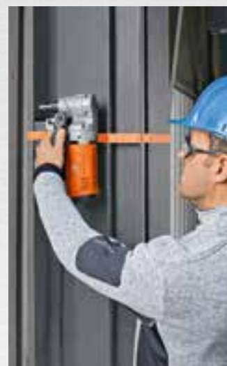
De asemenea, vertical și deasupra capului
