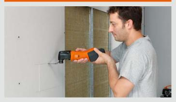
Le FEIN SUPERCUT est la machine oscillante la plus performante pour tous vos travaux de construction et de rénovation. Grâce à ses nombreux accessoires, vous découpez facilement les plaques pour la pose de cloisons sèches et les profilés de portes.
