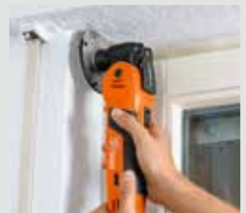
Ulkopuolisten kaihdinlaitteistojen suojusten purkaminen.
