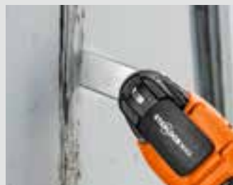
Elastisten saumatiivistysaineiden poistaminen maanpinnan ylä- ja alapuolisista rakenteista.
