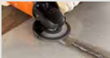
Application : ponçage rotatif du cordon de soudure.
