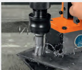
Perçage par carottage
