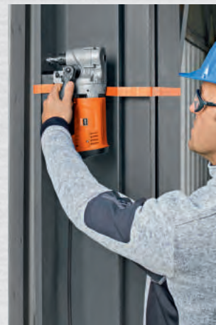
Egalement pour les travaux à la verticale et en hauteur
