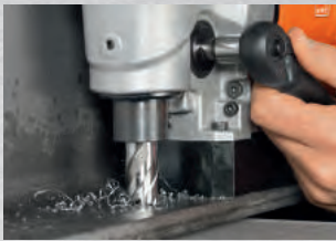
Perçage par carottage
