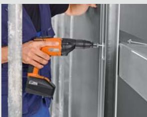
Los elementos de la fachada se atornillan directamente en las vigas de acero. El tope de profundidad ajustable evita daños debidos a tornillos demasiado apretados.
