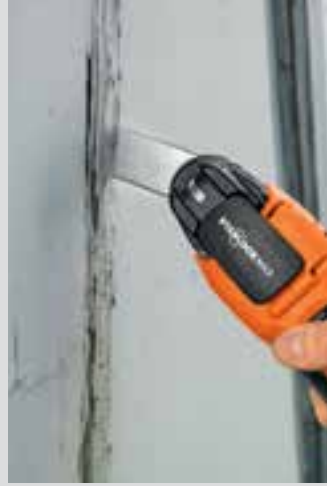
Yer üstü ve yeraltı inşaatlarındaki elastik derz sızdırmazlık maddelerinin çıkartılması.
