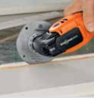
Cam pervazlarındaki çivilerin keserek ayrılması.
