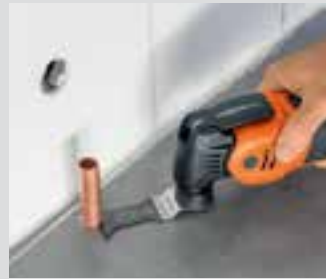
Eski tesisatların sorunsuz bir şekilde sökülmesi.
