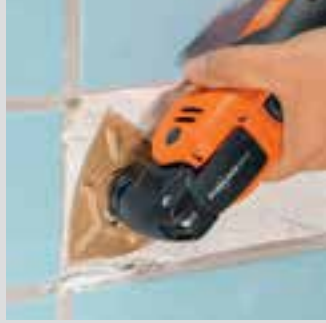
Yeniden derzlemeden önce, fayans yapıştırıcılarının zımparalanarak düzleştirilmesi.
