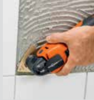
Fayans yapıştırıcılarının düz bir şekilde rasplanması.
