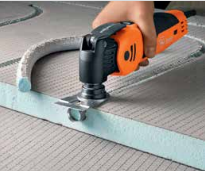
Sıcak su - yerden ısıtmalı kalorifer için kanalların kesilerek açılması.
