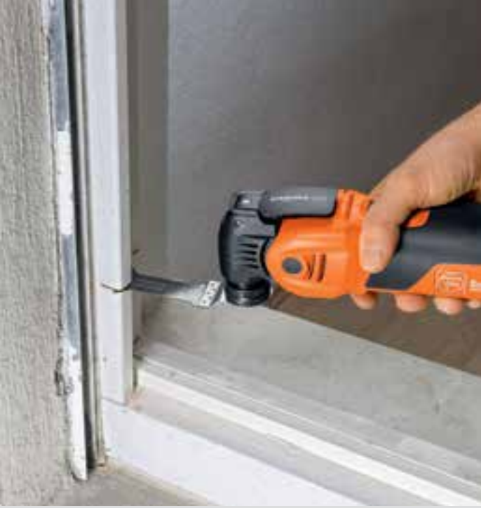
Pencere çerçevesinin keserek ayrılması.
