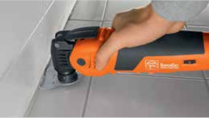
Elastik sızdırmazlık maddelerinin çıkartılması.
