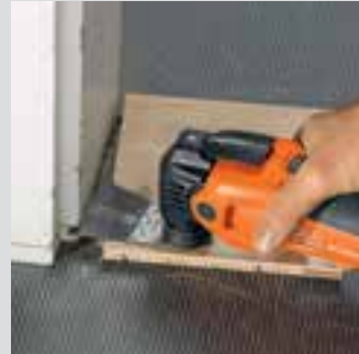
Yüzey ile aynı hizada çalışmalar.
