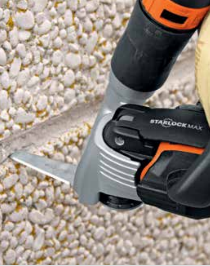
Tehlikeli derz malzemelerinde (örn. PCB) toz emme sistemi kullanılır.
