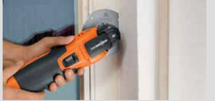
Eski pencerelerin sökülmesi sırasında metal bağlantı bantlarının keserek ayrılması.
