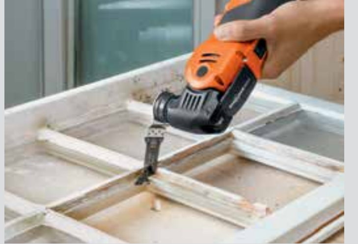
Eski pencerelerin restore edilmesi.
