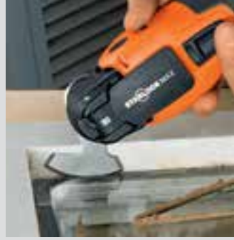
Macun yataklı izolasyon cam levhalarının çıkartılması.
