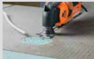
Elektrik tesisatına hazırlık yapılması.
