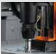
Perforación con corona
