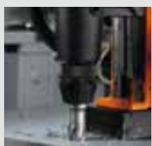
Perforación con corona
