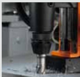
Perforación con corona
