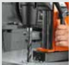
Perforación con broca espiral
