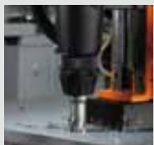
Perforación con corona
