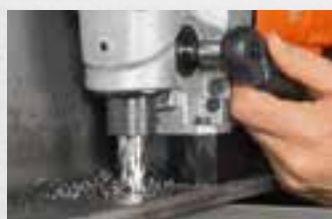
Perçage par carottage
