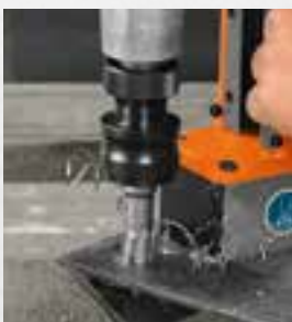
Perçage par carottage
