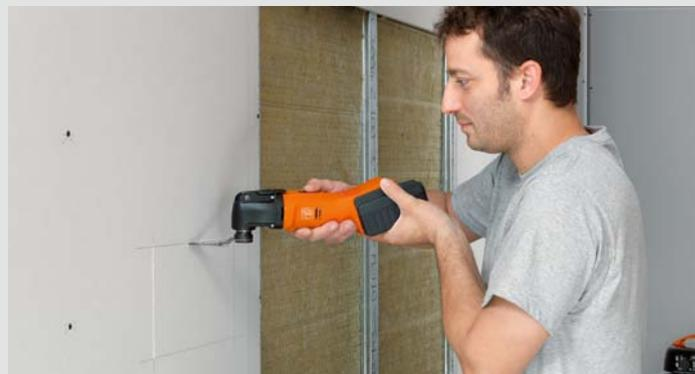
Il FEIN SUPERCUT è un potente utensile ad oscillazione per tutti i lavori di ristrutturazione e rinnovo. Grazie alla vasta gamma di accessori si possono tagliare anche pannelli in cartongesso e profili per porte.
